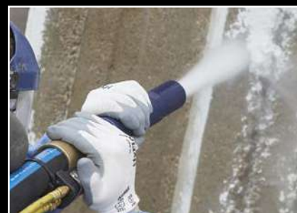
Nettoyage du béton
