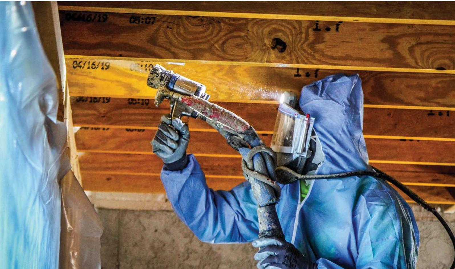
Le nouveau pistolet Fusion® PC™ peut être reconstruit plus rapidement à l'aide d'une simple cartouche de rechange.
