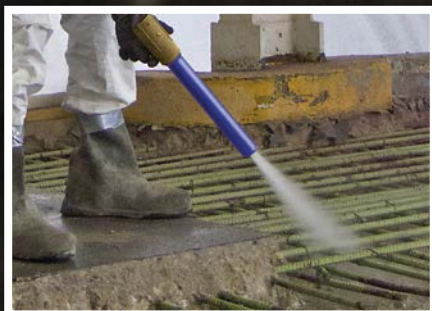
Réparation et restauration du béton
