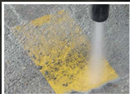
Nettoyage du béton et préparation de surface
