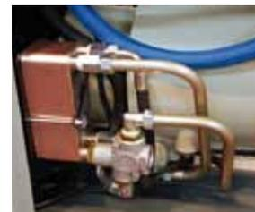
Le kit "Récupération Chaleur" est parfaitement intégré au circuit de refroidissement de l'huile. Ainsi, l'équipement est autonome quant au contrôle de la température de l'huile et protégé des éventuelles anomalies, telles que la réduction du débit d'eau ou la surchauffe.
